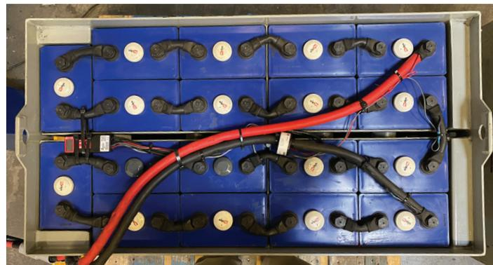
Figura 8: Montaje final del dispositivo Wi-iQ4 en cofre de bloques de 12 V
